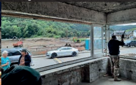
Bilder vom Arbeitseinsatz: Einsetzen der durchsichtigen Platten – im Inneren des Hauses ist nicht mehr viel Brauchbares.
