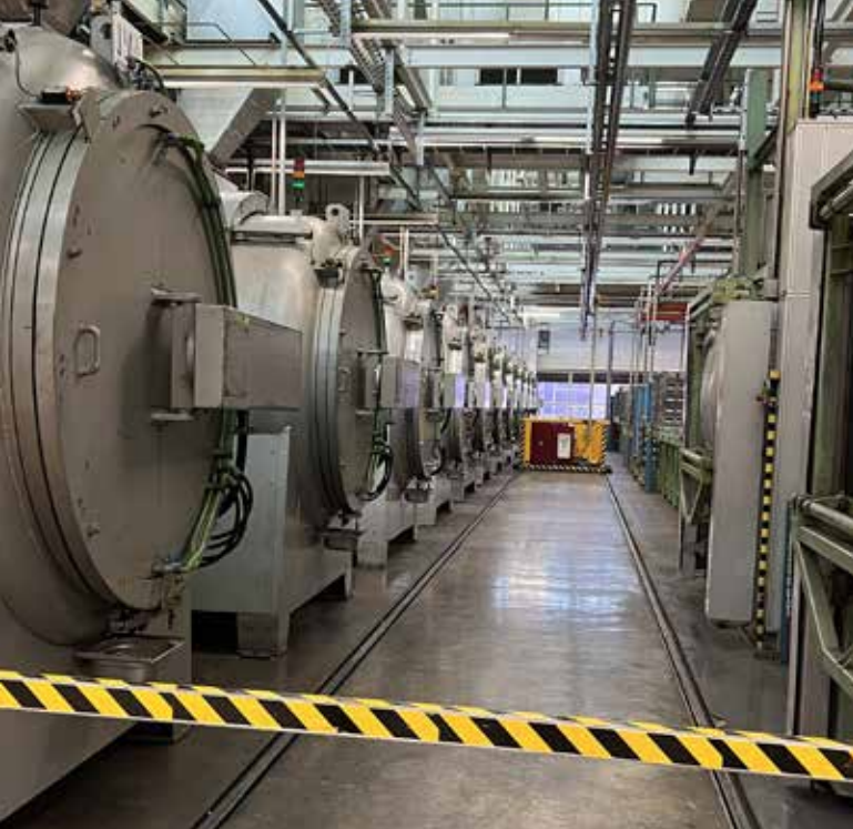
Werkteil Hedelfingen: Vorbereitung der Nitrieröfen im Gebäude 41 für die Wiederverwendung (Re-Use).
