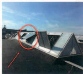
Die Klappen fahren bei über 17 Grad Außentemperatur in den Übergangsmonaten auf. Die Klappen schließen bei unter 17 Grad und bleiben im Hochsommer (hohe Außentemperatur) dauerhaft geschlossen.
