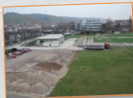
November: 300 Einstellungen für 2014 und ein neues Gebäude für die Motorenproduktion soll auf dieser Fläche gebaut werden
