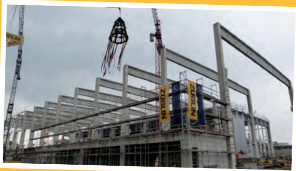
Richtfest auf der TÜBA – hier entstehen zwei neue Betriebsmittelbauhallen
