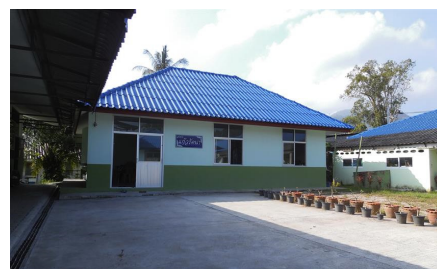
Nachher: Das neue Küchengebäude
