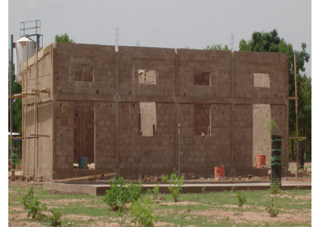
Der Rohbau ist fertig ... (Stand Juli 2014)
