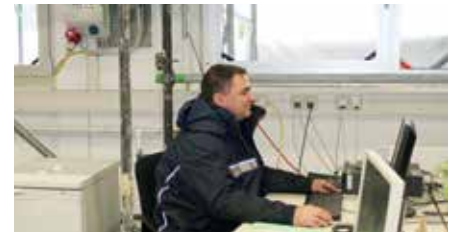
An der Fensterfront fehlen noch Heizkörper. Sie müssen dringend vor dem Winter eingebaut werden
