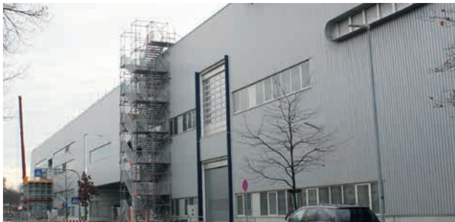
Das zum Ausbau der Fertigungskapazitäten im Motorenbereich gebaute Gebäude 148/2 ist mittlerweile fertig gestellt
