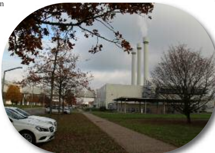
Die Energiezentrale im Werk Rastatt
