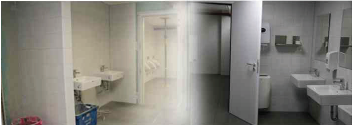
Die Sanitärräume sollten bereits im Dezember fertiggestellt werden. Das linke Foto entstand Ende Januar 2016. Inzwischen hat sich einiges getan, das rechte Foto zeigt den aktuellen Stand.
