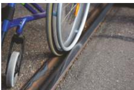
Gefährliche Falle. Schnell gerät man mit dem Rollstuhlrad in die Schienen der Werksbahn.
