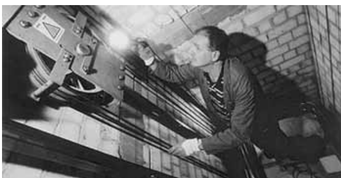
Moderne Aufzugskabine - alte Steuerungstechnik
