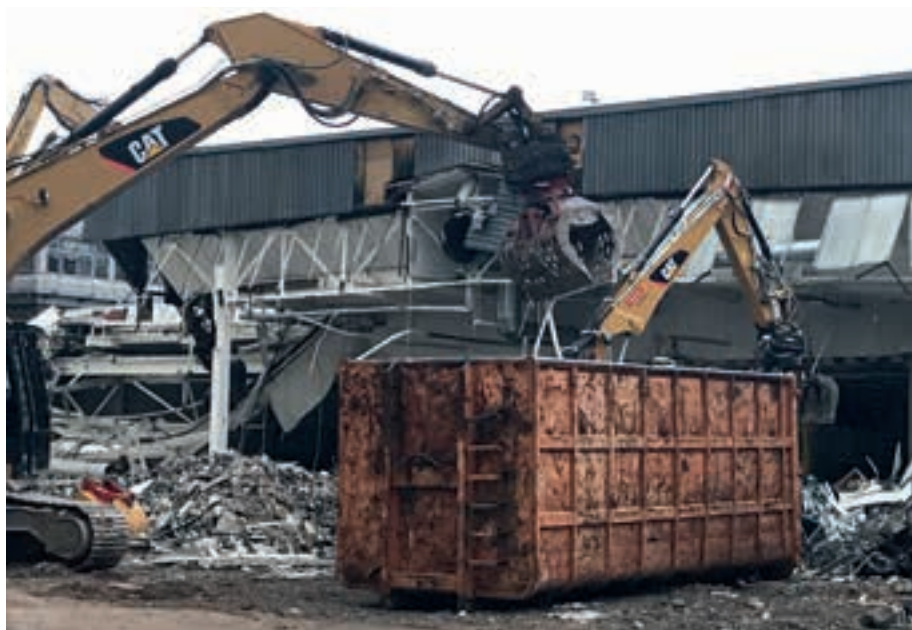
Abriß des Betriebsmittelbaus in Untertürkheim
