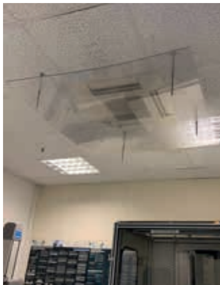
Die Lüftung wurde vorerst mit Plexiglas abgedeckt
